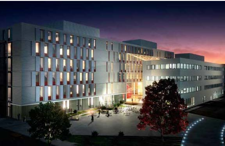
Prof. Brocks gate 2, Trondheim. Beregnet levert energi: under 80 – 100 kWh/m 2 år (variabel informasjon). Ferdigstilt 2009. Illustrasjon: PKA Arkitekter
