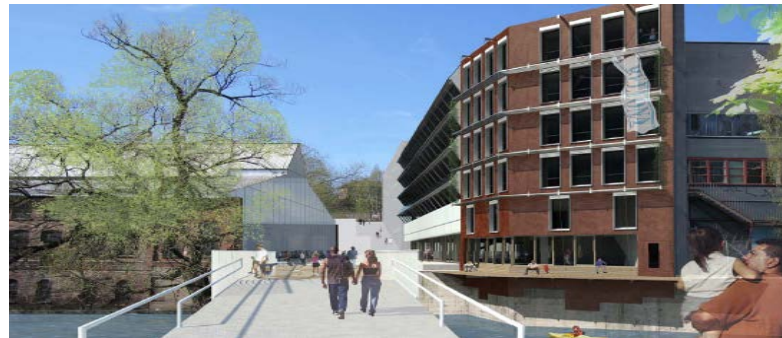
Bellona-bygget, Oslo. Norges første A-merkede kontorbygg. Levert energi 70 - 80 kWh/m 2 år. Ferdigstilles i 2010. Kilde: Aspelin Ram
