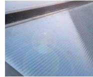
TAK SOLCELLEPANELER OG SOLFANGERE
