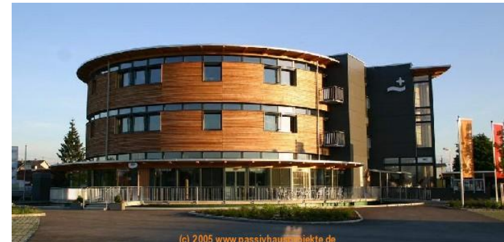
PH office in Stadl-Paura, Austria. Source: www.passivhausprojekte.de
