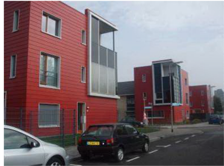
Vannsolfangere (hus nærmest) og solceller (hus nr. 2) i fasader i passivhus i Roosendal i Nederland. Kilde: SINTEF Byggforsk
