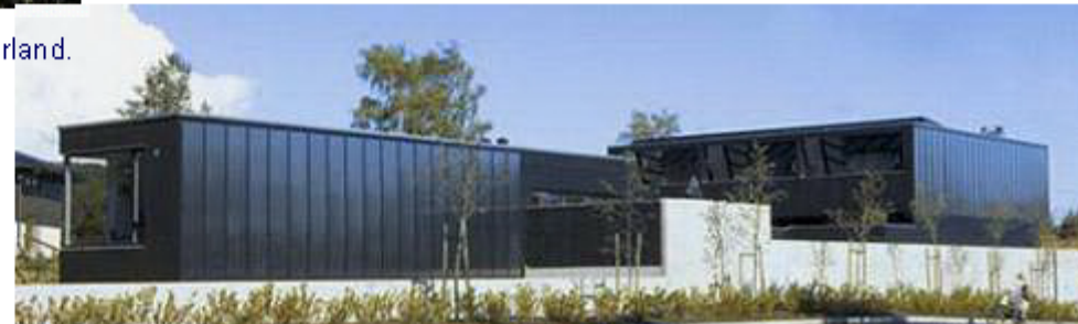
Boligprosjekt i Oslo med vannsolfangere i fasadene. Kilde: SOLARNOR
