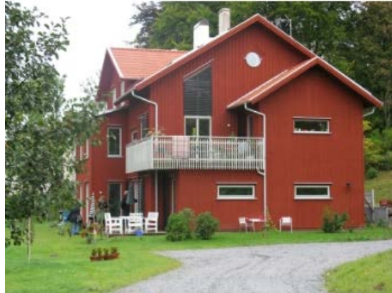
Firemannsbolig med passivhusstandard i Vårgårda utenfor Gøteborg. Kilde: www.passivhuscentrum.se
