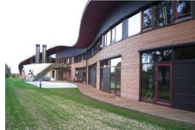
Passivhusskole i Aufkirchen, Tyskland.. Kilde: www.passivhausprojekte.de
