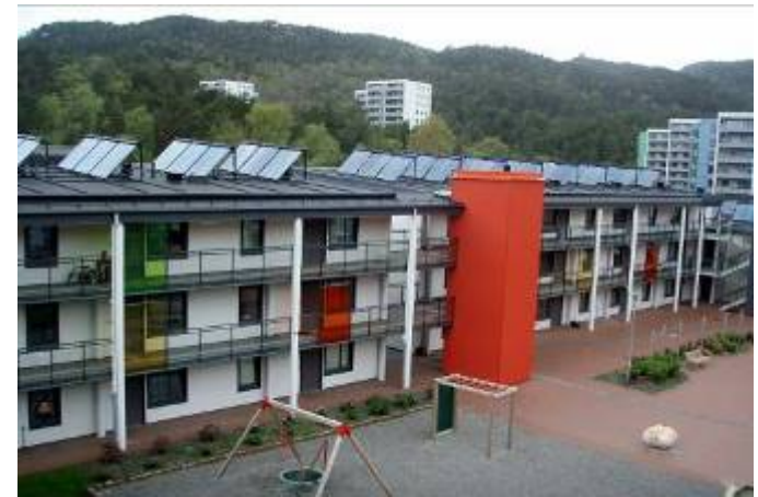
Passivhusprosjektet Løvåshagen i Bergen, med vakuumsolfangeranlegg. Foto: SINTEF byggforsk
