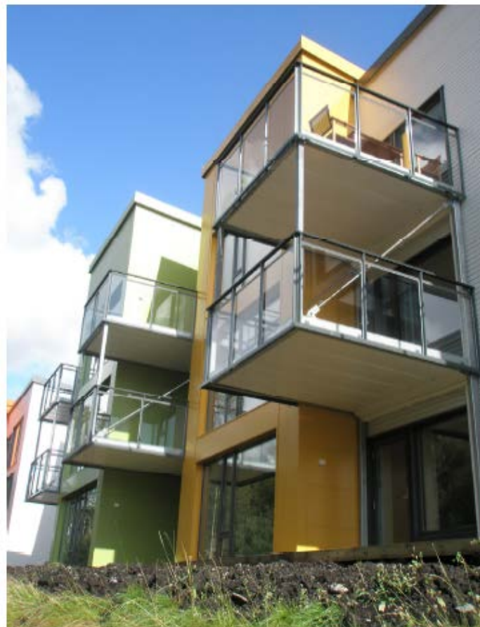
Løvåshagen: 14 leiligheter med passivhusstandard bygget i Fyllingsdalen utenfor Bergen. Første lavblokkbebyggelse med passivhusstandard i Norge. Arkitekter: ABO PLAN & ARKITEKTUR. Foto: SINTEF Byggforsk.
