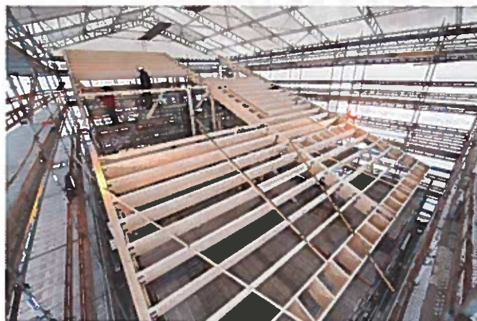
Takkonstruksjonen og etasjeskillene ble bygd med kraftige limtrebjelker. (Foto: Christian Sømme, Optimera)
