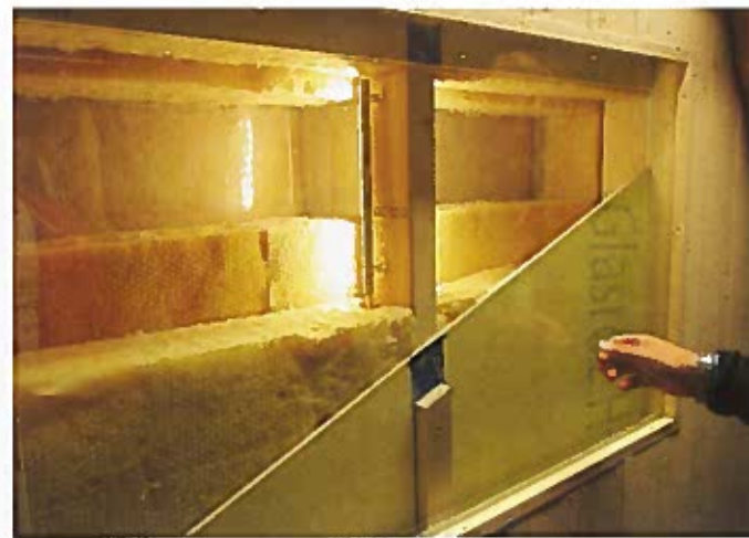
En av veggene inne er gjennomskåret for å vise hvordan den er bygd opp. (Foto: Ingvar Skarvang)
