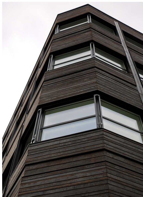
Norges første: Powerhouse Kjørbo i Sandvika utenfor Oslo er landets første rehabiliterte plusshus. FOTO: MONA STRANDE
